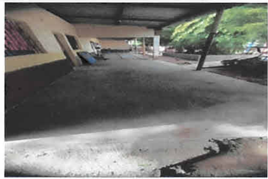
Foto 4: FUNDICIÓN DE PISO DE CONCRETO
