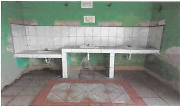
Foto 5: INSTALACIÓN DE LAVAMANOS
