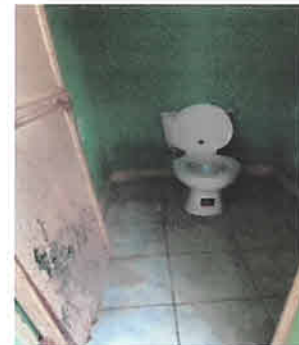
Foto 6: INSTALACIÓN DE SANITARIOS
