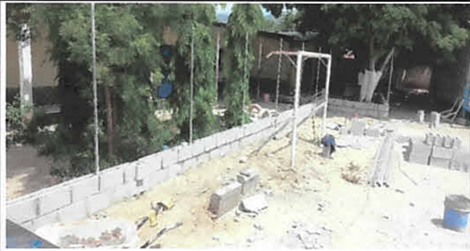
Foto 1: MURO DE BLOCK CON TUBO HG Y MAYA GALVANIZADA
