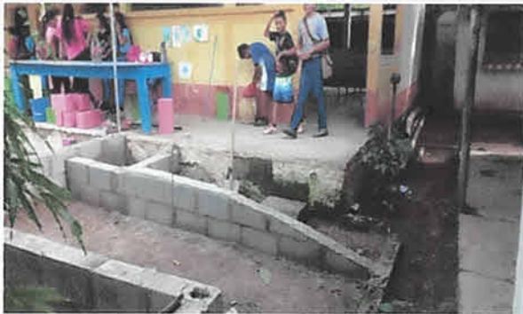
Foto 3: RAMPA PARA EL ACCESO A LAS AULAS
